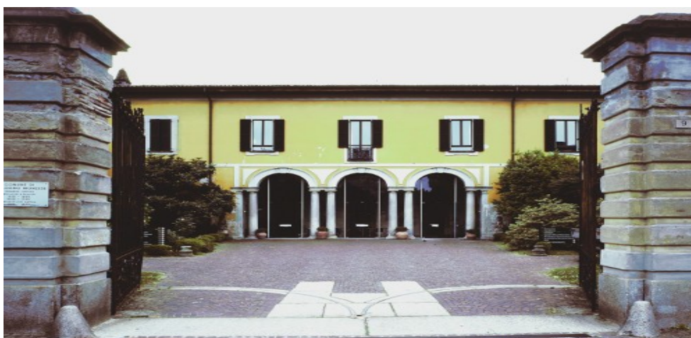
(Fig. 1) Facciata principale.
